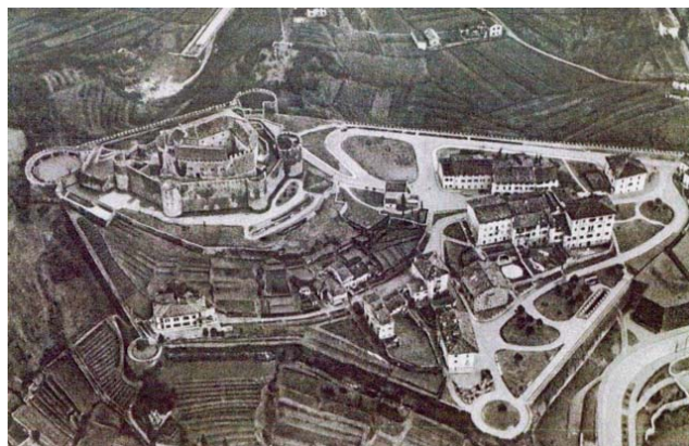
fig. 1 - Il Castello ed il Borgo a conclusione dei lavori di ricostruzione. (cartolina collezione Roberto Ballaben)
