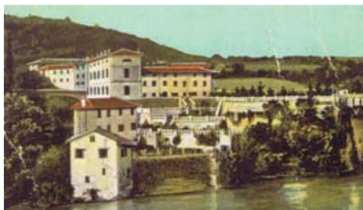
ig.2 - Le case Fogar al Ponte di Piuma prima dello scoppio della Grande Guerra (cartolina collezione Roberto Ballaben)
